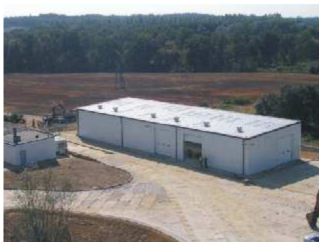
Hala do magazynowania i podczyszczania odpadów segregowanych Tak jest w 2006 r.
