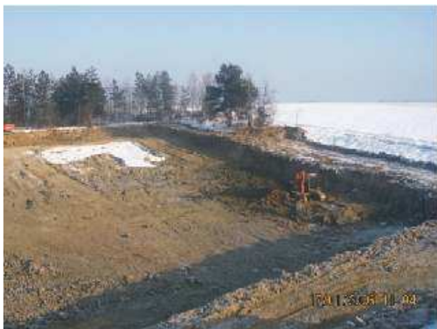
Nowa kwatera komunalna w trakcie budowy
