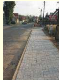
Teraz budujemy chodniki przy ul. Oleśnickiej
