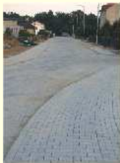
Ul. Kilińskiego po przebudowie
