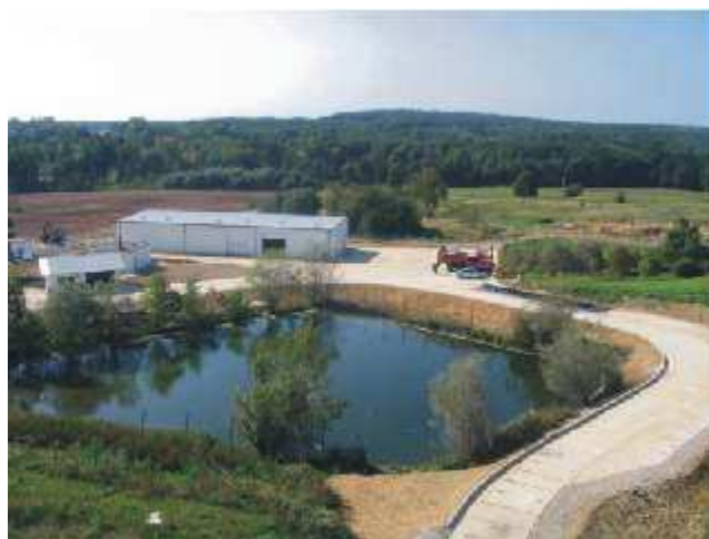
Place i drogi wewnętrzne Tak jest w 2006 r.
