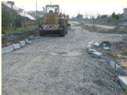
Trwa budowa drogi i chodników w ul. Rzemieślniczej
