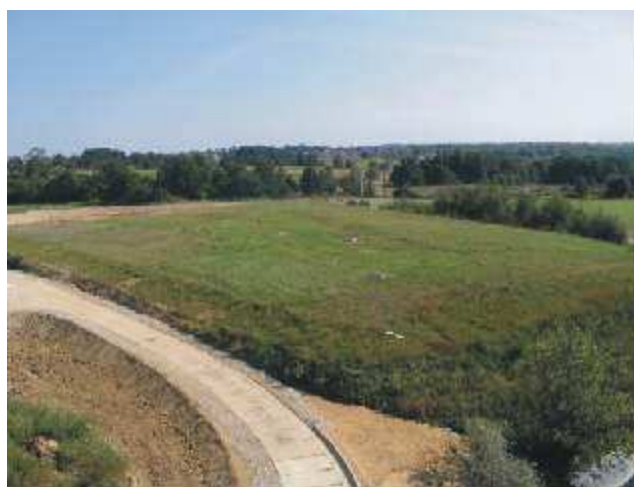
Stara kwatera na odpady komunalne zrekultywowana w 2005 r.
