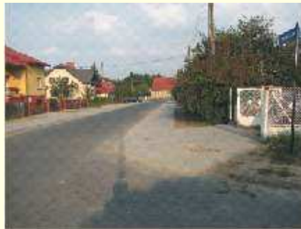
Chodniki na ul. Norwida, Prusa i Słowackiego już gotowe
