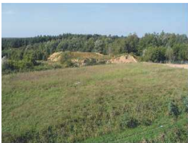
Stara kwatera na odpady przemysłowe zrekultywowana w 2004 r.
