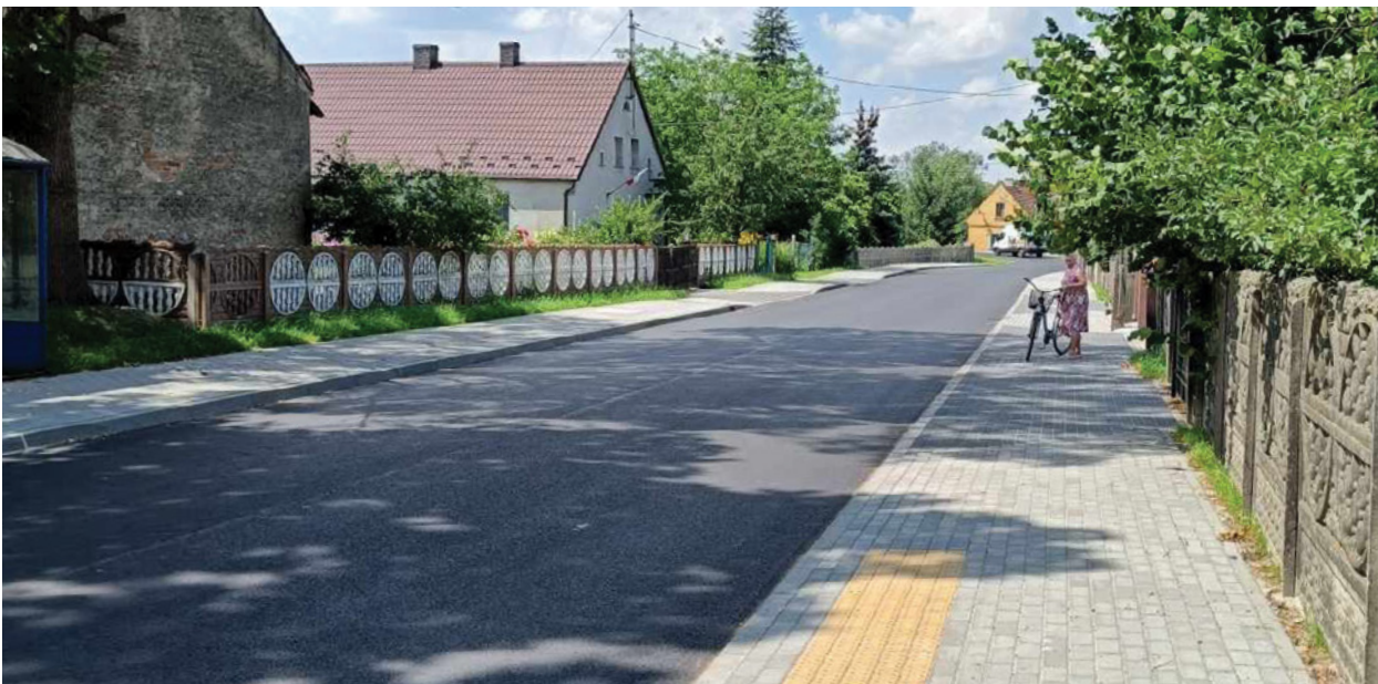
Ukończony odcinek drogi w Domasławicach
