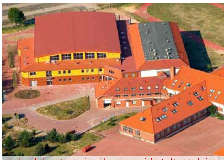
budowa hali sportowo-widowiskowej wraz z infrastrukturą techniczną i zagospodarowaniem terenu
