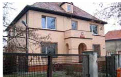
remont budynku Komisariatu Policji
