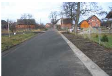
budowa drogi relacji Bukowinka - Białe Błoto
