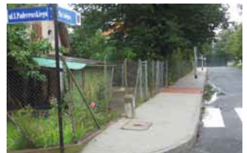
budowa chodnika w ul. Paderewskiego i pl. Kolejowym
