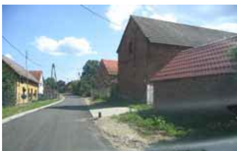
modernizacja drogi gminnej w Grabownie Małym
