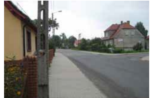
remont chodników przy ulicy Oleśnickiej
