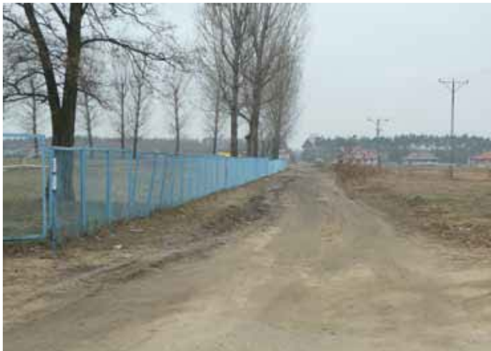
przebudowa ulicy Sportowej
