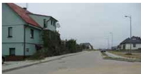
budowa wodociągu oraz kanalizacji sanitarnej i deszczowej w ul. Sportowej, Polnej, Akacyjnej, Kasztanowej, Wierzbowej i Bukowej w Twardogórze
