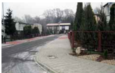
budowa chodników w ul. H. Wiernego, W. Łokietka, B. Chrobrego, W. Warneńczyka
