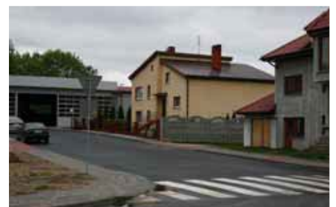
remont ulicy Kruczej
