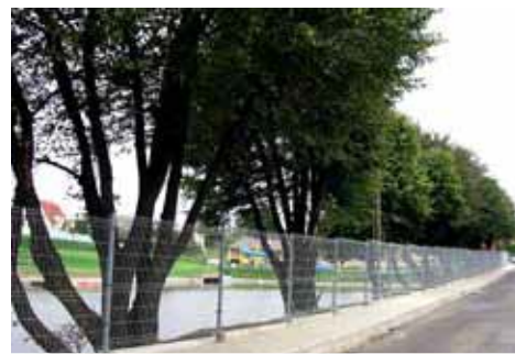
wymiana ogrodzenia wokół basenu
