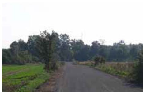
przebudowa nawierzchni drogi w Grabownie W. - droga dojazdowa do składowiska odpadów
