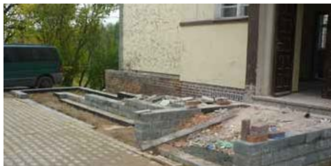
Podjazd przy świetlicy w Chełstowie
